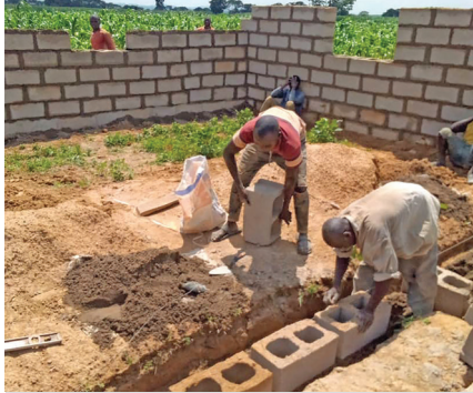
Ya se están construyendo los dos primeros centros de salud.
