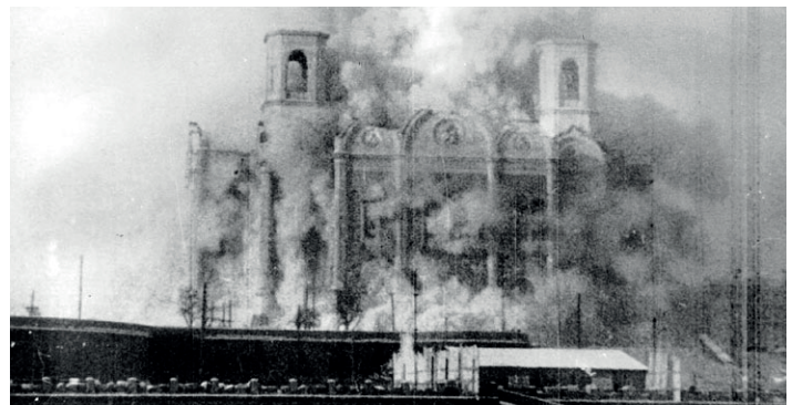
La demolición de la Iglesia de Cristo Salvador en Moscú, 1931.
