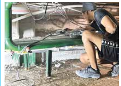
Trabalho financiado pelo Barnabas em andamento no porão da igreja
